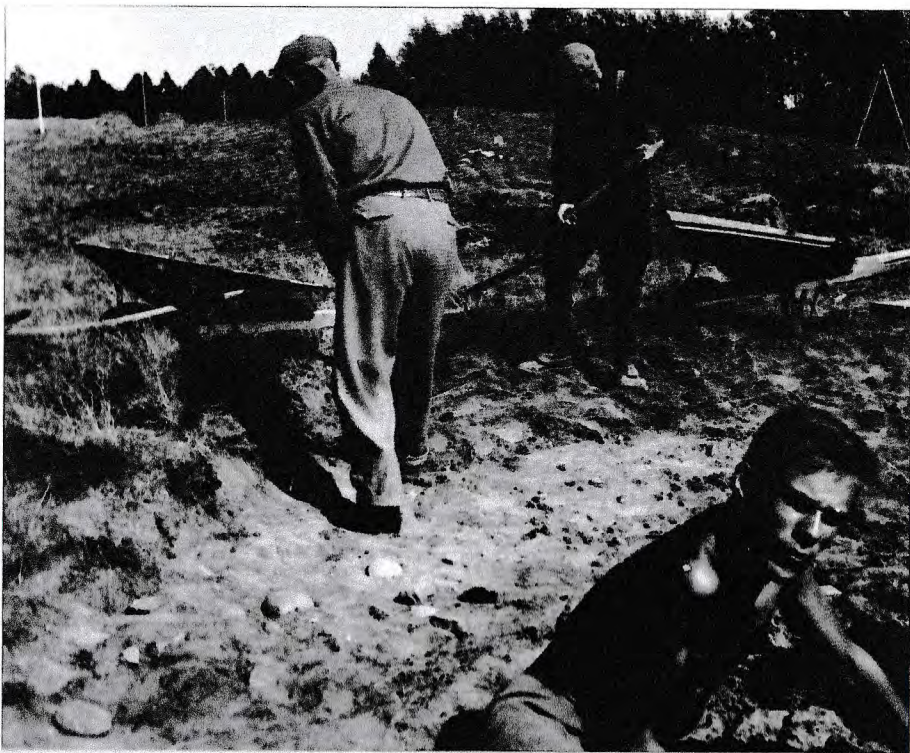
2. Dåtiden grävmaskiner var inte det bästa hjälpmedlet utan större delen av området frilades med skyfflar. På den undre bilden av det bröderna Kruse som har det tunga arbetet medan Lennart Karlsson rensar fram delar av en grav på ett mindre arbetskrävande sätt.
